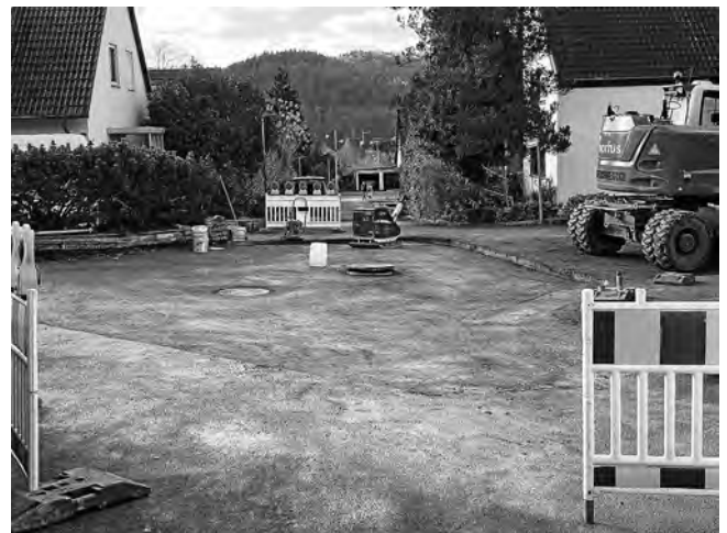
Baustelle Kanalsanierung Fotos: Gemeinde Plüderhausen
