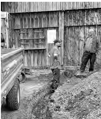
Roman Gaissert und Eugen Rube besprechen die Schachtarbeiten für den Rohrgraben der Wasserleitung.
