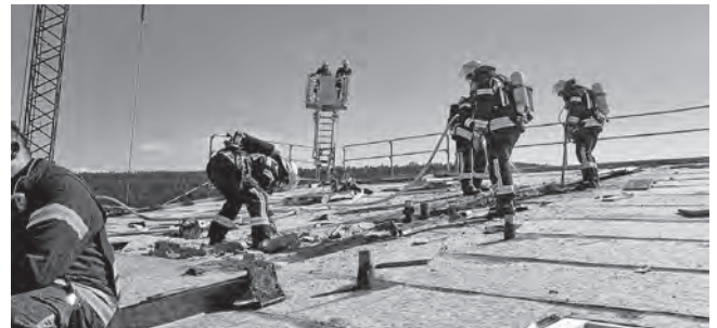
Unter schwerem Atemschutz wird die Dachhaut geöffnet und die Glutnester freigelegt.
