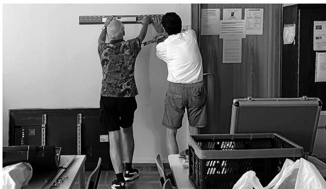
Vorbereitung der Gerätemontage
