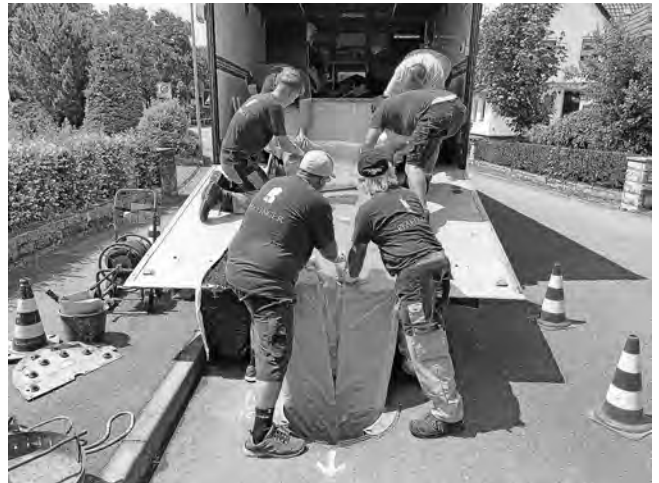
Mitarbeiter der Fa. Pfaffinger beim Einbringen eines Inliners in die Kanalisation in der Ahornstraße
