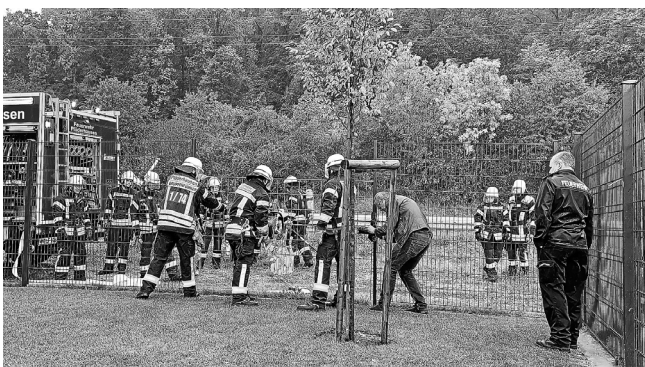
Schaffung eines Zugangs zum Betriebsgelände
