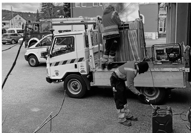
Mobile Betankung für das Notstromaggregat durch das Bauhofteam
